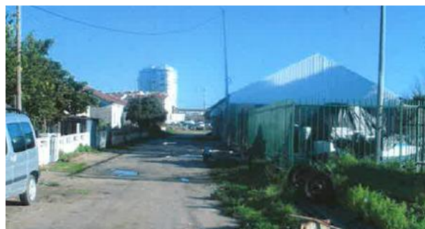
Vista geral das construções
